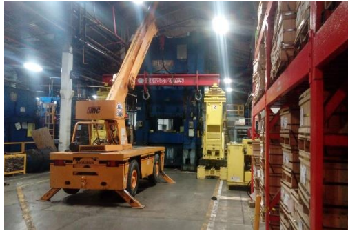
Figura 5. Operación de izaje.
