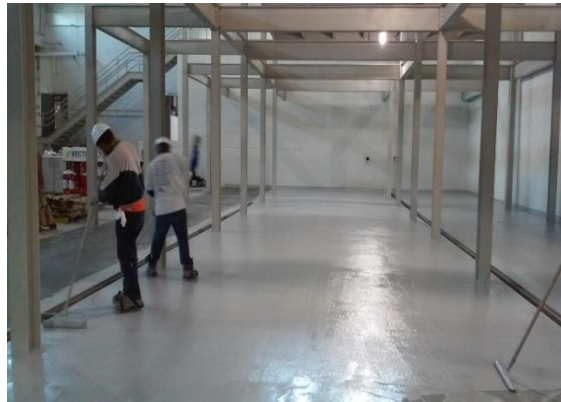
Figura 22: Suelo construido con resina epoxi.
