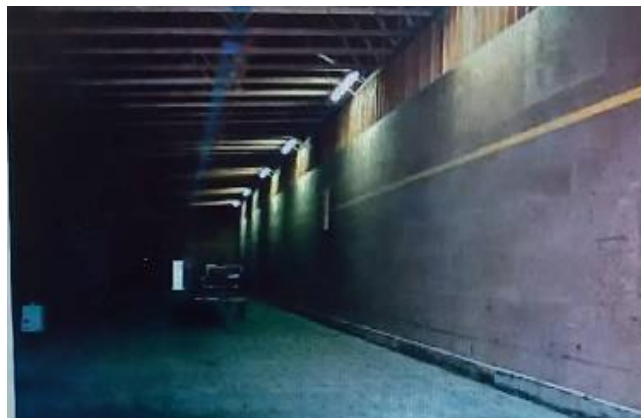
Ilustración 4. 127. Instalación de ventilación forzada.
